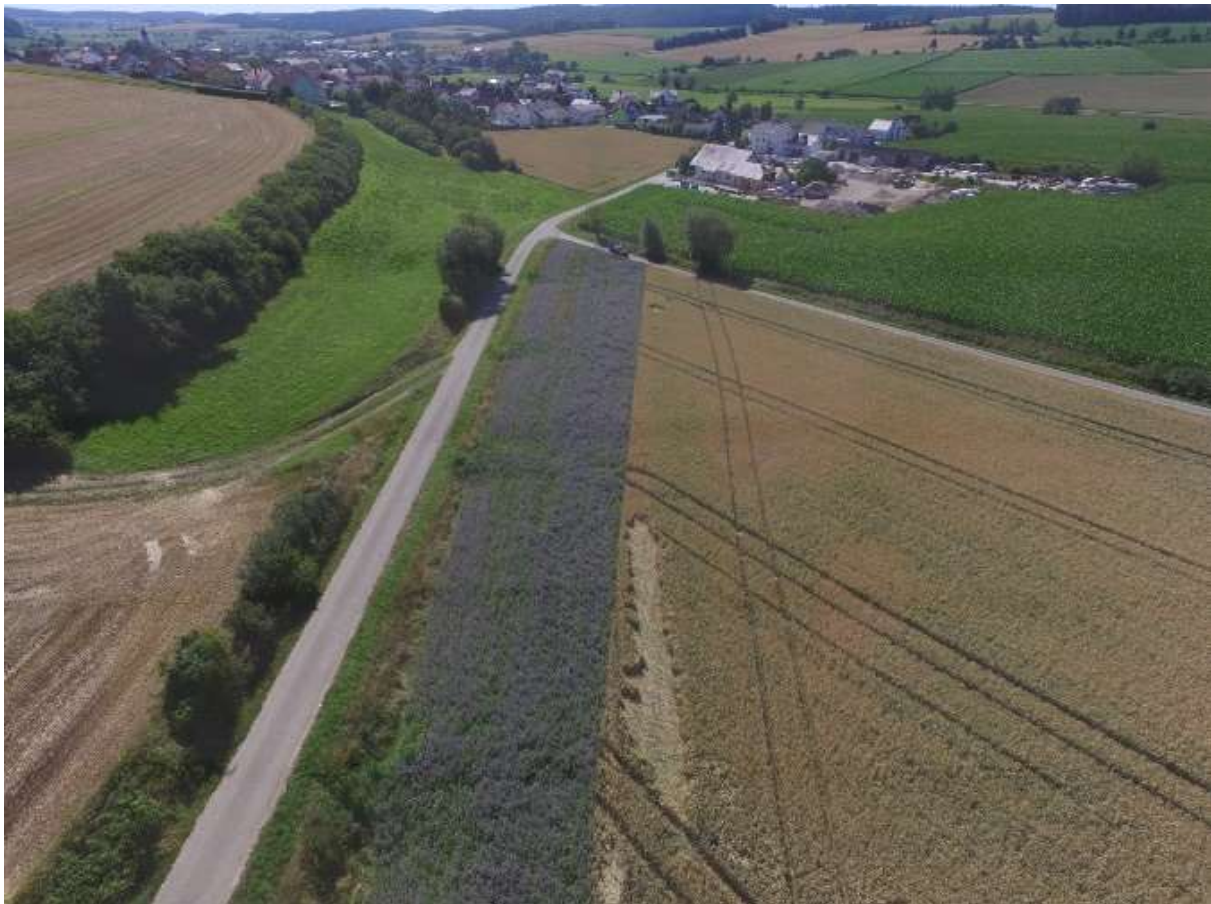
Abb. 41: Als Rückhaltestruktur ausgebauter Grünweg bei Jauchshofen, Nov. 2017
