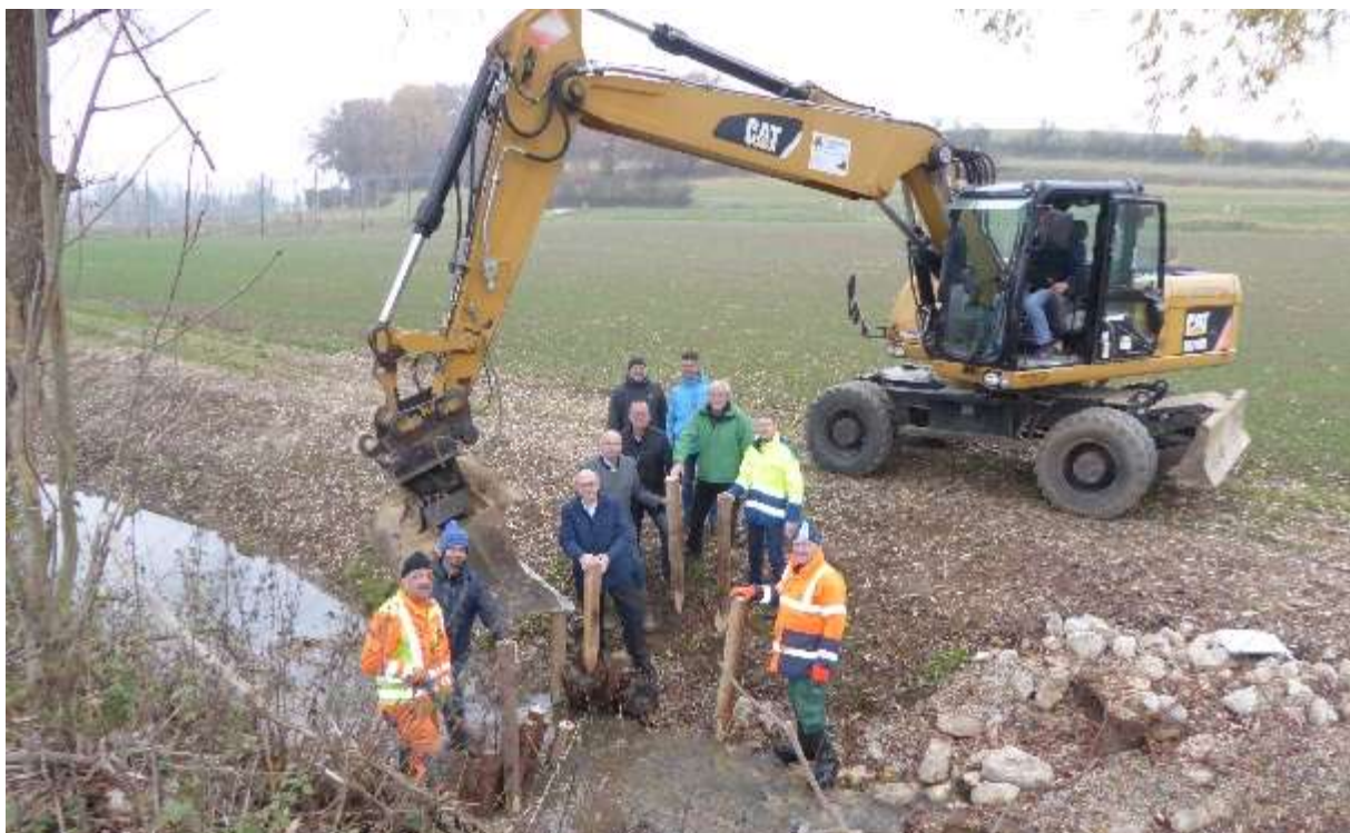
Abb. 40: Pressetermin zum Abschluss der Renaturierungsmaßnahme am Elsendorfer Bach
